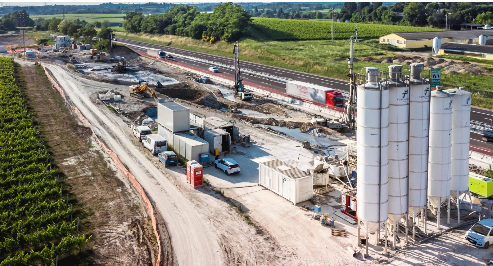
Vista del cantiere di San Giorgio di Sonza dall'alto.
